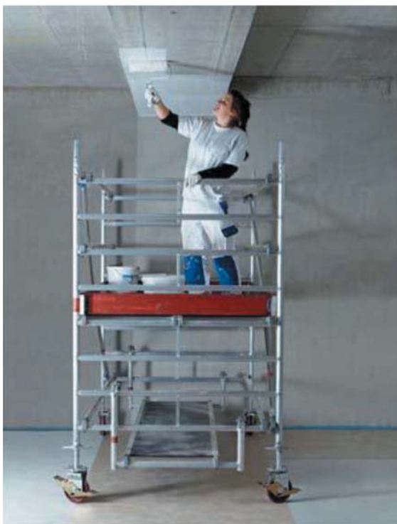
Рисунок 16. Передвижные подмости правильной конструкции в использовании
