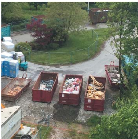
Рисунок 4. Пример правильно организованного места сбора строительных отходов
