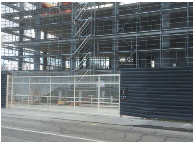
Рисунок 2. Ограждение строительной площадки
