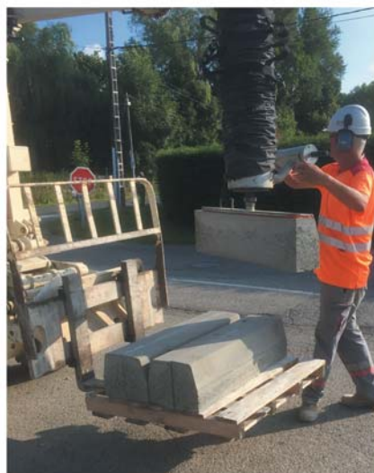
Рисунки 37 и 38. Погрузчик с вакуумным захватом для бордюрного камня
