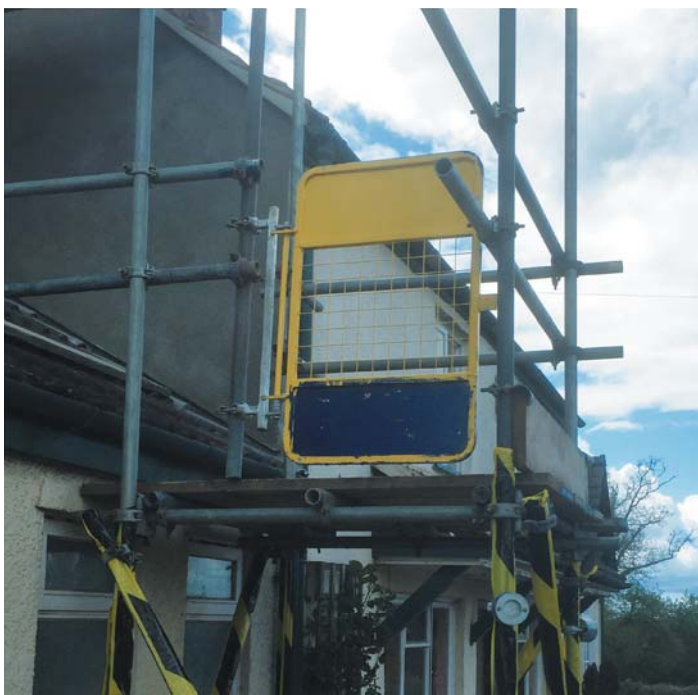
Рисунок 13. Самозакрывающаяся дверь на точке входа на леса
