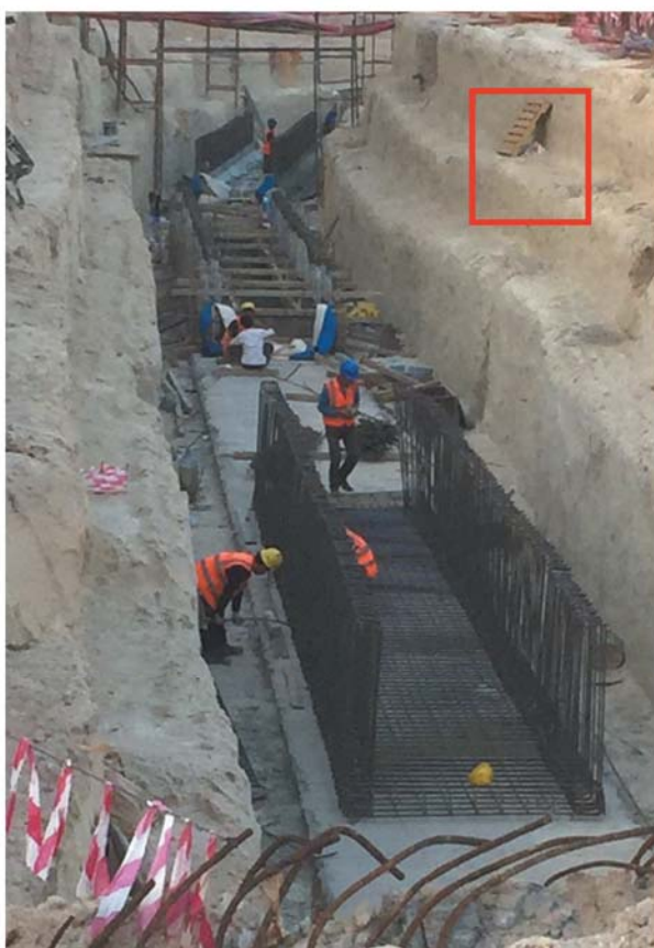
Рисунок 33. Рабочие, выполняющие работы в котловане
