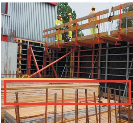
Рисунок 5. Незакрнутая стержневая арматура представляет опасность
