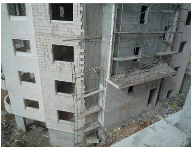
Рисунок 7. Пример небрежного содержания рабочих зон, когда строительные отходы могут упасть на находящихся внизу работников, которые, кроме этого, подвергаются другим опасностям при проходе по этому замусоренному участку
