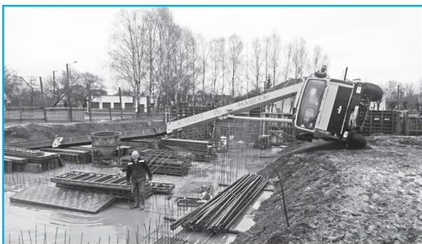
**21.02.2015** на строительном объекте, расположенном на территории ОАО «Мозырский НПЗ», при перемещении (без груза) стрелы гусеничного крана МКГС-100, принадлежащего одному из открытых акционерных обществ, произошло запрокидывание гуська и стрелы на находящуюся в непосредственной близости эстакаду.
